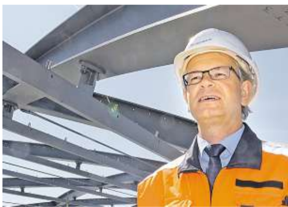
Projektleiter Dirk Göhring ist mit dem Fortgang der Arbeiten auf der U-4-Baustelle Elbbrücken zufrieden: „Wir liegen im Zeitplan.“
